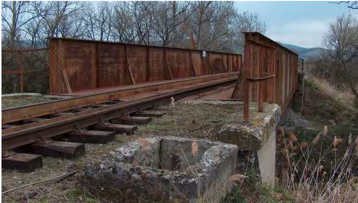
31. kép - Vasúti hídszerkezet Nógrádszakál árterében
