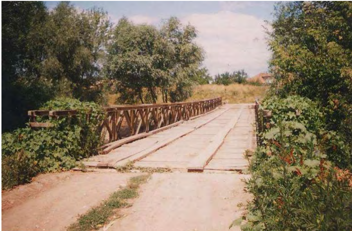
24. kép - A Bailey-bridge Tésa és Szete között (2001)
