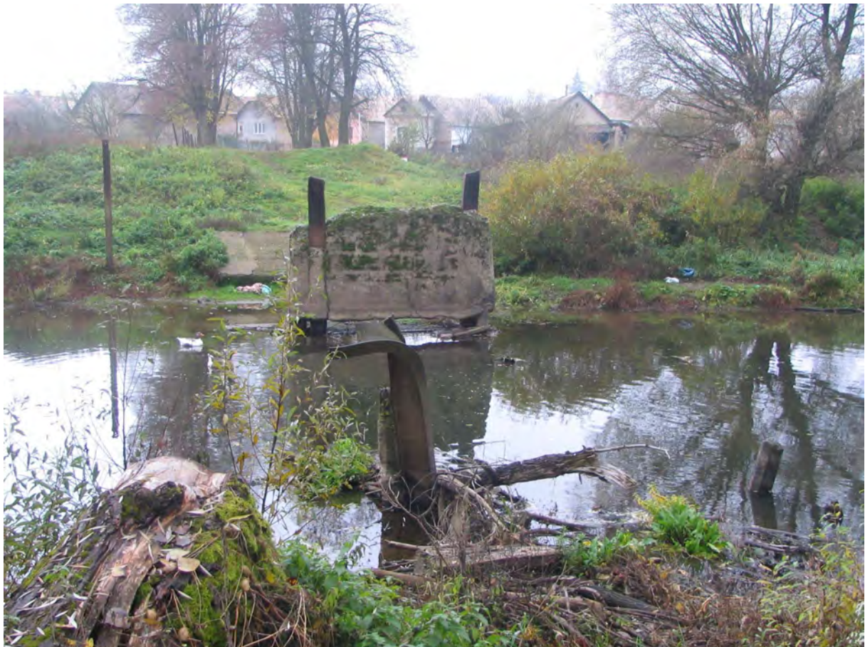
9. kép - A rárósmúlyadi hídmaradványok (2007)
