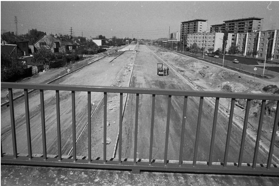
12. ÁBRA AZ M3-AS AUTÓPÁLYA ÉPÍTÉSE A BUDAPESTI BEVEZETŐ SZAKASZON
