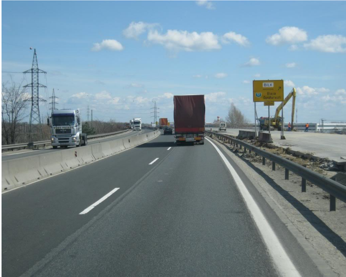
13. ÁBRA AZ M0-ÁS KÖRGYŰRŰ DÉLI SZEKTORA. KÖZÉPEN BETONOSZLOPOKKAL VALÓ ELVÁLASZTÁSA SOK AUTÓS KÖRÉBEN NÉPSZERŰTLEN VOLT. MELLETTE FOLYNAK A KISZÉLESÍTÉSI MUNKÁLATOK (FORRÁS: WWW.SKYSCRAPERCITY.COM , 2015)
