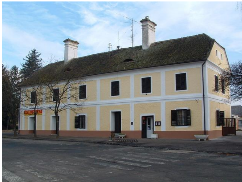
2. ábra: Az Aranybárány Fogadó épülete
